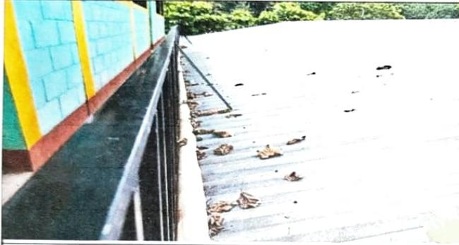
Foto 7: Sustitución de Canal de PVC
