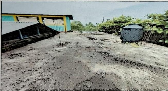
Foto 3: Impermeabilización de losa y Reparación de Pañuelos.
